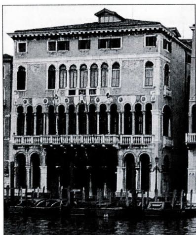
Palazzo di Ca' Loredan, veduta dell'esterno.
