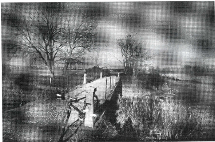
ponticello sulla Piave Vecchia
