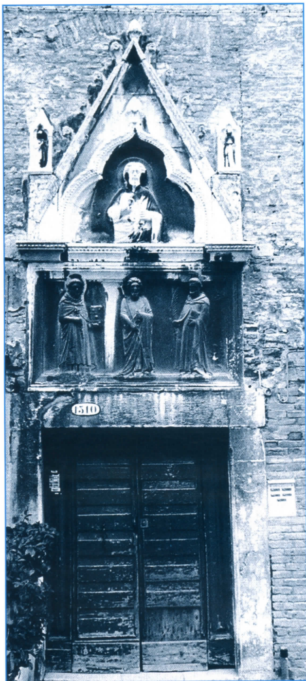
■ Via Garibaldi, Porta de le Putte
