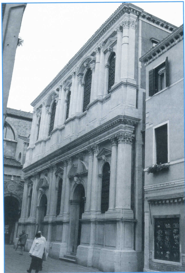
■ Facciata della scuola verso campo Santa Margherita.
