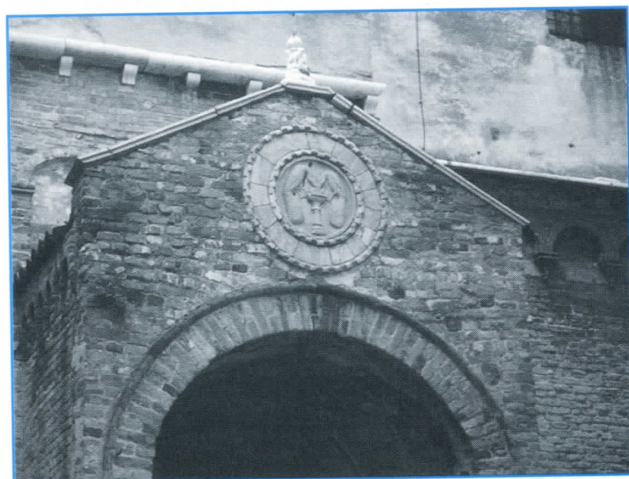
■ La patera del protiro trecentesco del portale laterale sinistro.
