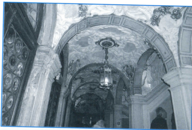
■ Soffitto del pianerottolo mediano della scala.
