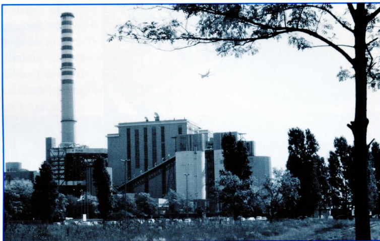
■ Centrale termoelettrica di Fusina.
