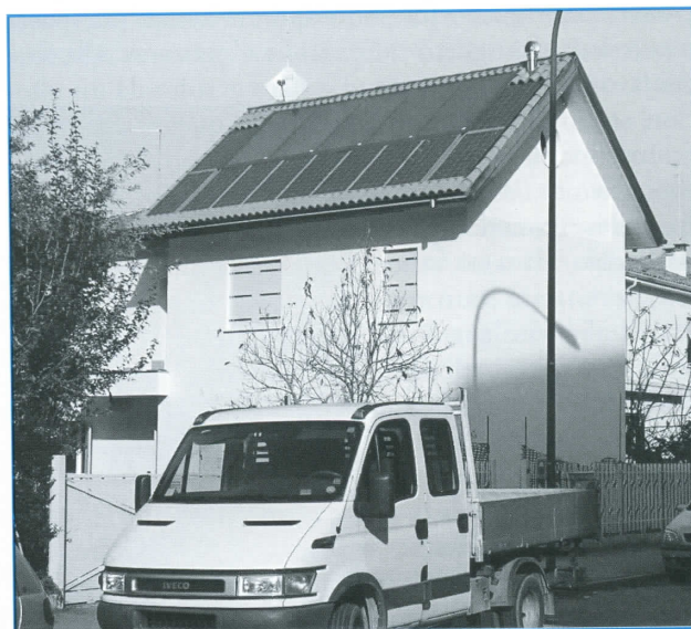
■ dopo il restauro.
