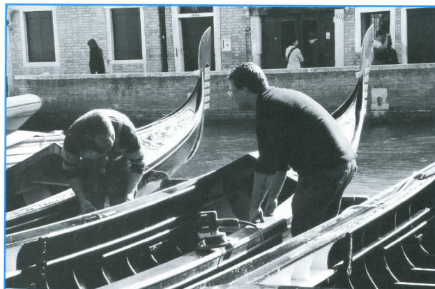
■ Operai al lavoro.
