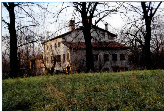
Una delle fattorie rimaste, ancora abitata, visibilmente soffocata dalla discarica che la circonda.
