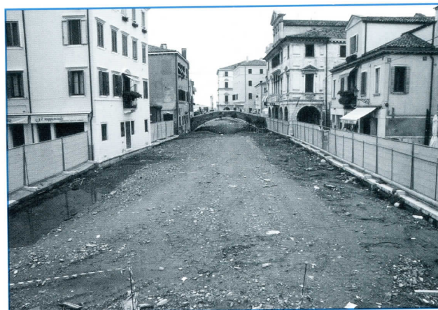
■ Canale interrato per lavori di consolidamento delle rive e delle fondazioni.
