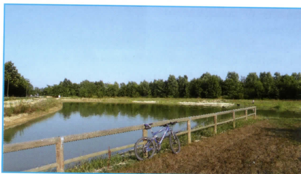
Nuovo lago di espansione.
