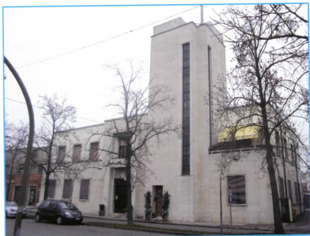
■ Ex casa del Fascio, attuale Caserma.
