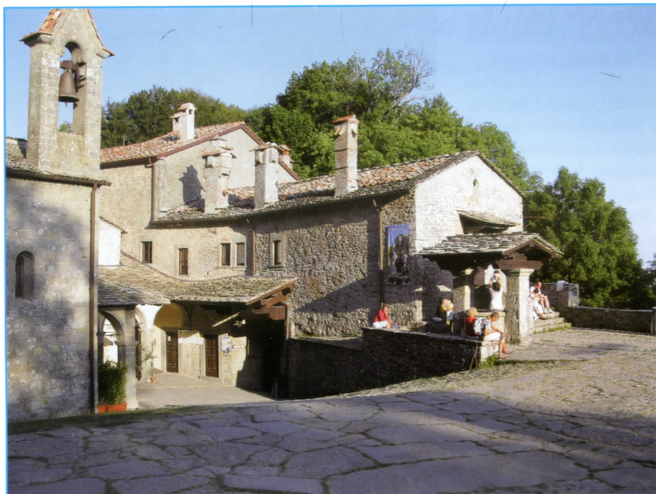
Il vecchio Convento dal piazzale del Quadrante. A sinistra scorcio sul campanile e il portico della chiesina di Santa Maria degli Angeli.
