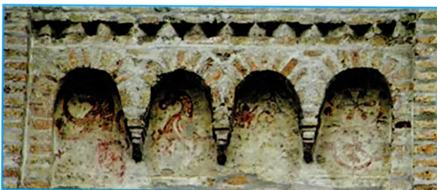
Fig. 2 Particolare della torre carrarese di Zianigo trasformata in campanile, sono ancora presenti simboli e animali appartenenti a stemmi nobiliari.
