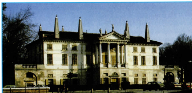
■ Attuale facciata di villa Foscari Rossi.
