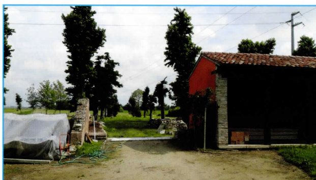
■ Le serre di villa Migliorini: prima del tornado, subito dopo e oggi dopo il parziale ripristino.
